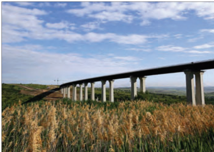
Le développement des infrastructures reste l'un des enjeux majeurs du développement économique de la Roumanie. Ici, l'autoroute Sibiu-Orăștie, toujours en travaux.
