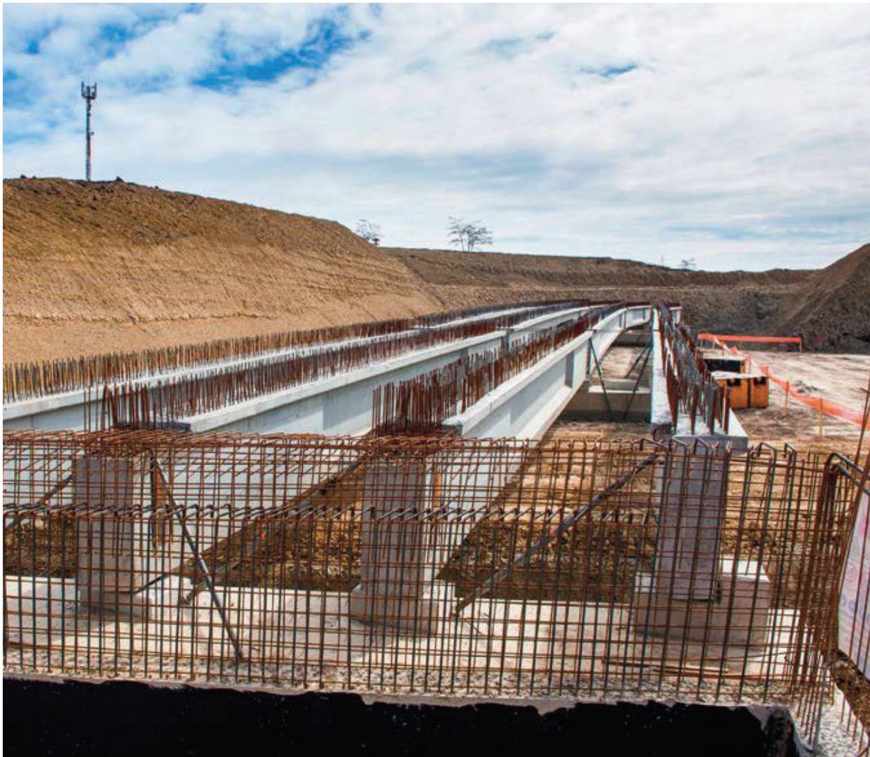
Chantier de l'autoroute Sebeş-Turda, en avril dernier.
