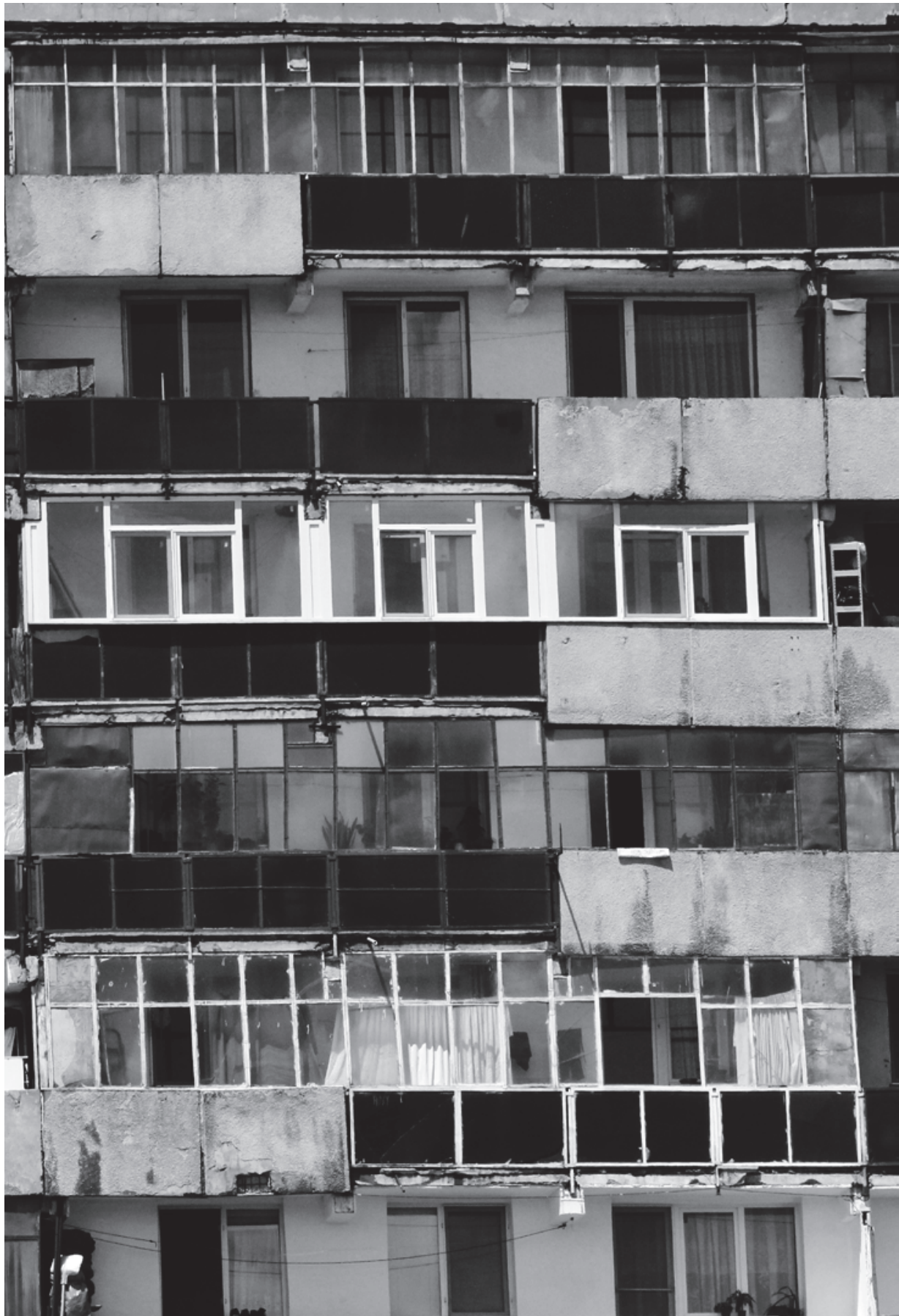
Située sur la rue Prelungirea Ferentari, cette barre d'immeuble est, avec ses dix niveaux, la plus haute des environs. Les quelques commerces installés au rez-de-chaussée et la proximité de la ligne de tramway en font l'un des lieux les plus fréquentés du coin.
