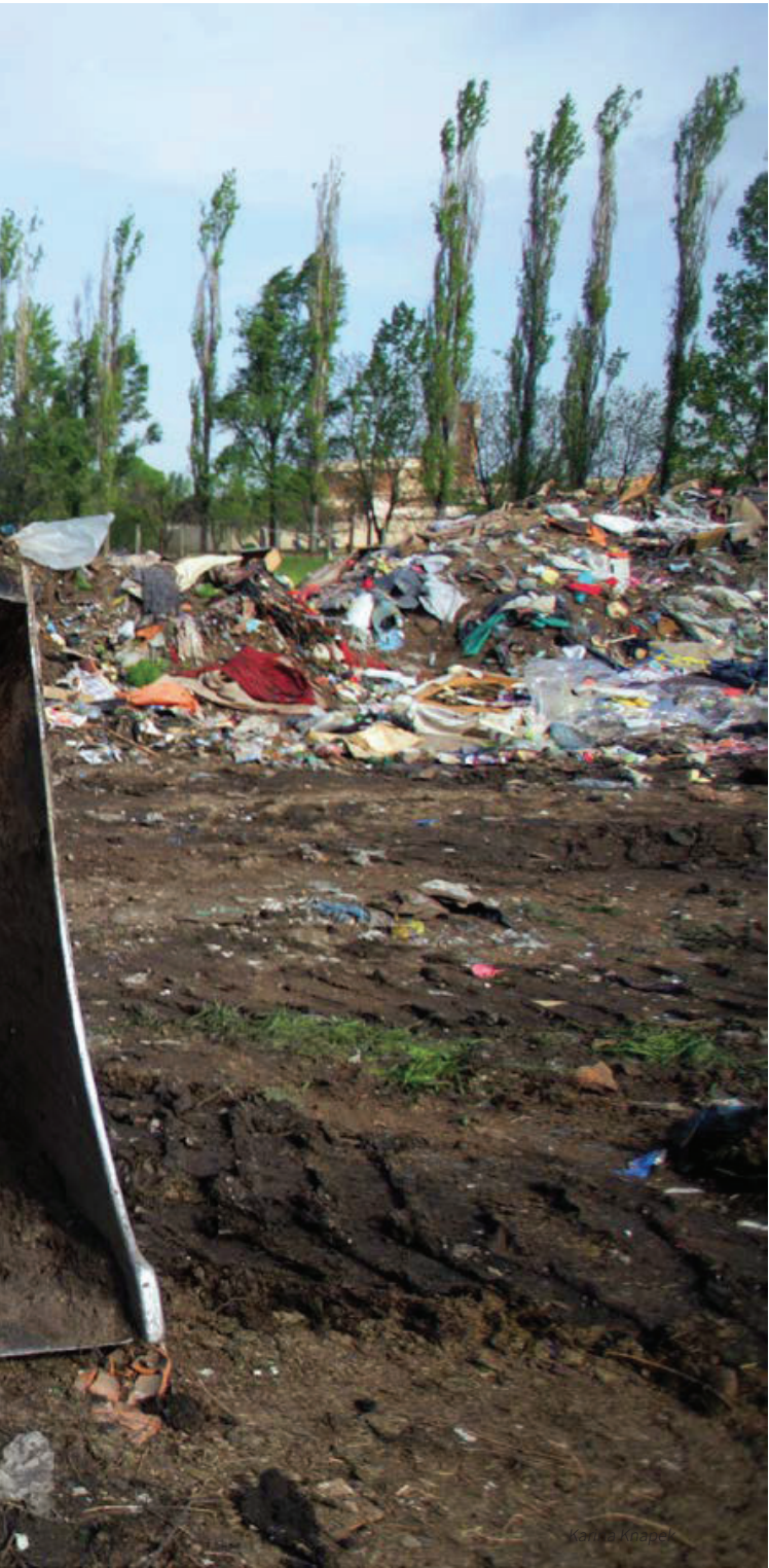
Photo prise à l'été 2008 lors de la démolition de logements improvisés dans le quartier Militari de Bucarest.
