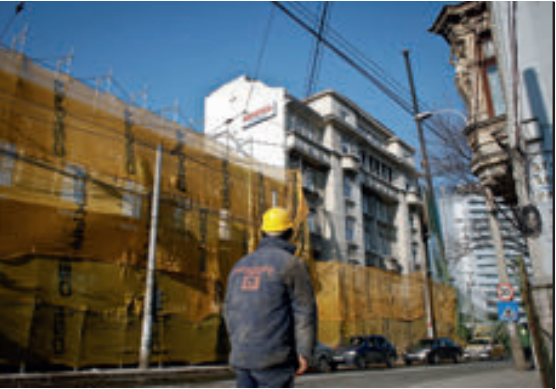
Décembre 2010, Bucarest, sur calea Buzesti, près de Piata Victoriei, l'hôtel Mama est en passe d'être démoli, construction du boulevard Uranus oblige...
