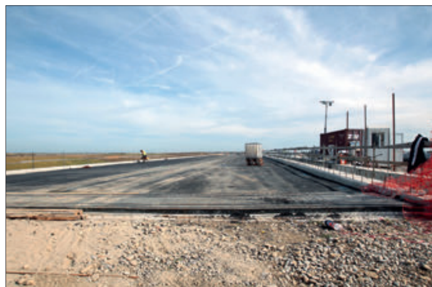
Travaux sur le tronçon Bucarest-Moara Vlasiei de l'autoroute Bucarest-Brasov (septembre 2011).
